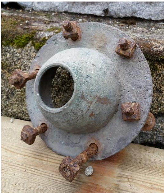
Messingdysa som strøyppte vannstrålen inn på peltonturbinen
