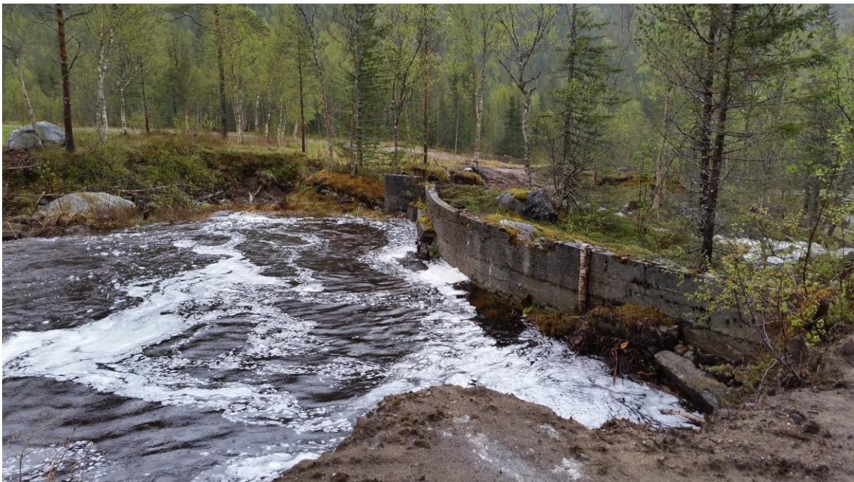
Dammen slik den står i dag. Under bevaringsarbeidet sommeren 2020 ble en god del masse gravd ut av dammen slik at det dannet seg et vannspeil, selv om plankedelen i nordøst er borte. Kratt og skog er ryddet slik at støypmuren er synlig igjen.
