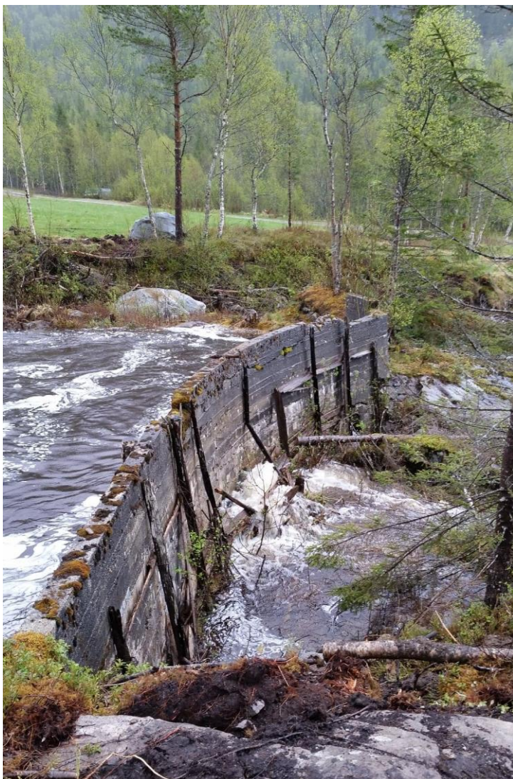
Betongdelen av demningen
